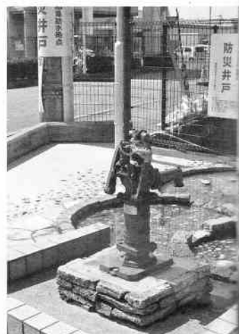
防災会が敷地内に掘った防災井戸。毎分140リットル近い水量があり、災害時には近隣にも開放する。飲むこともできる
